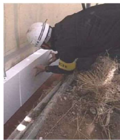
外壁の断熱化工事
