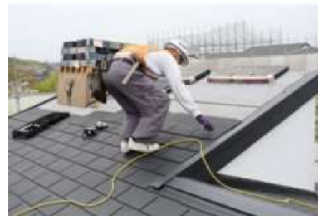
屋根の断熱化工事
