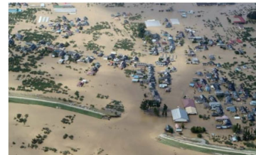
長野市長沼穂保での堤防決壊箇所
