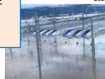
浸水した北陸新幹線車両基地
